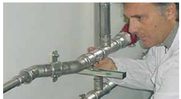
Obr. 23 – Kontrola lisovaného spojení
