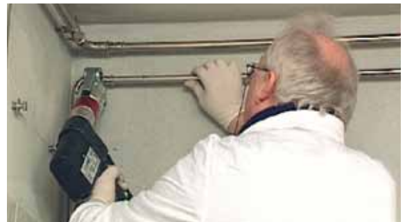
Obr. 22 – Zhotovení lisovaného spojení
