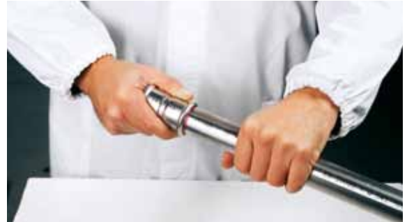
Obr. 21 – Zavádění trubky do lisovací tvarovky
