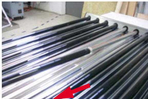
**2.** poškozenou vakuovou trubici odtáhnout (stáhnout) směrem šikmo nahoru
