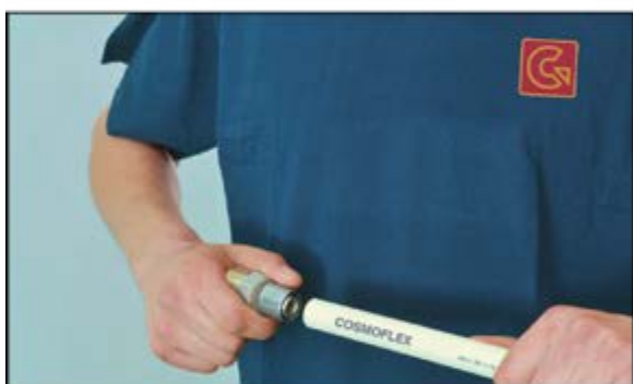
Vsunutí tvarovky COSMOFLEX.PRESS na zkalibrovanou a odhrotovanou trubku COSMOFLEX.
