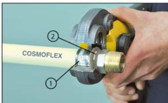
Pohled na správně provedenou lisovací operaci potrubí COSMOFLEX s tvarovkou COSMOFLEX.PRESS
