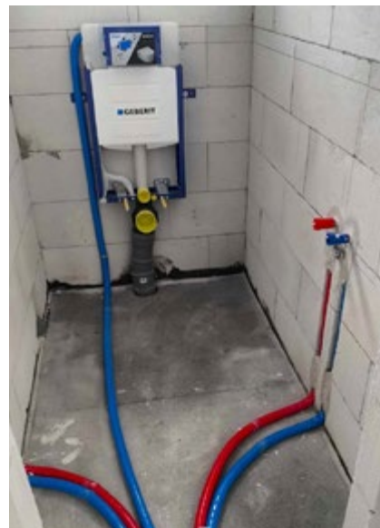
Fixační kroužek s průhledítkem (červený): bezpečné a těsné spojení s optickou kontrolou pozice trubky
