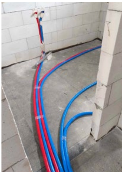
Ručně tvarovaný oblouk pomocí ohýbací pružiny
